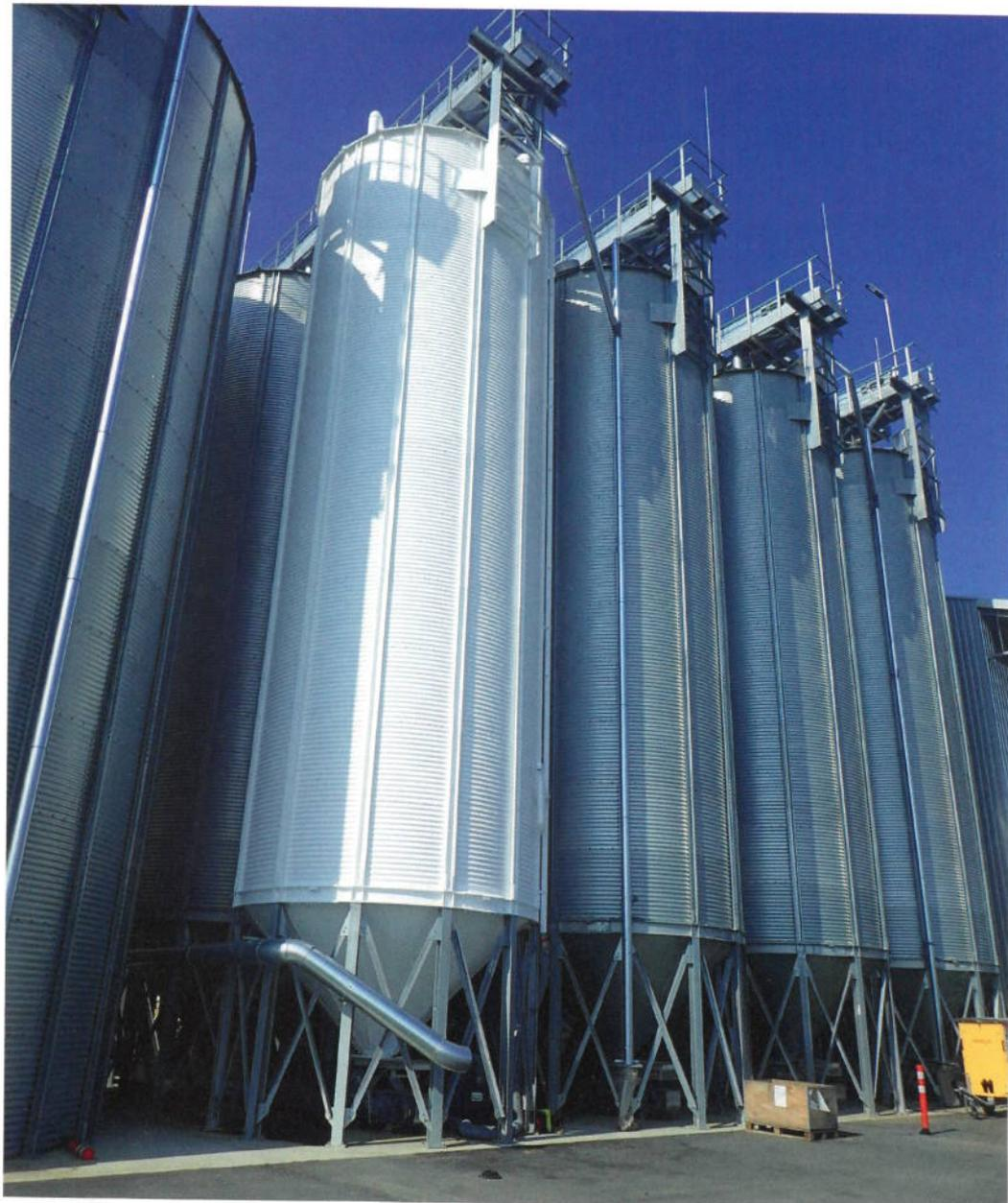
Testung eines innovativen australischen Verfahrens im VSnet-Projekt zur gasdichten Getreidelagerung: Ein Silo wurde mithilfe einer weißen Farbeschichtung nach australischem Standard gasdicht umgebaut.
